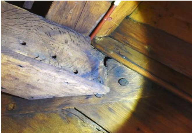
Gebint 13 C-zijde aansluiting met gebint 15, afgezaagde dekbalk
