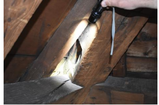
Halfgebinten/hoekkepers 25,27,28 en 29 zijn vervaardigd met spantbenen van volledige gebinten. De sparingen ten behoeve van voormalige pen- en gat verbindingen zijn loodrecht op het zijvlak
