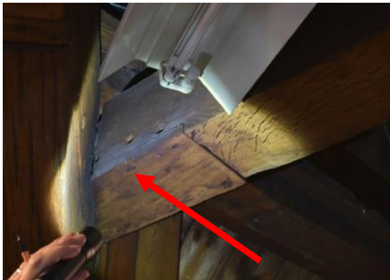
Gebint 13 D-zijde aansluiting met gebint 15, afgezaagde dekbalk
