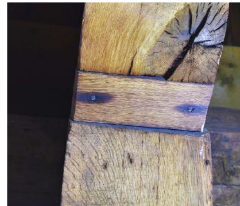
Onderzijde dekbalk, aanpassing korbeel
