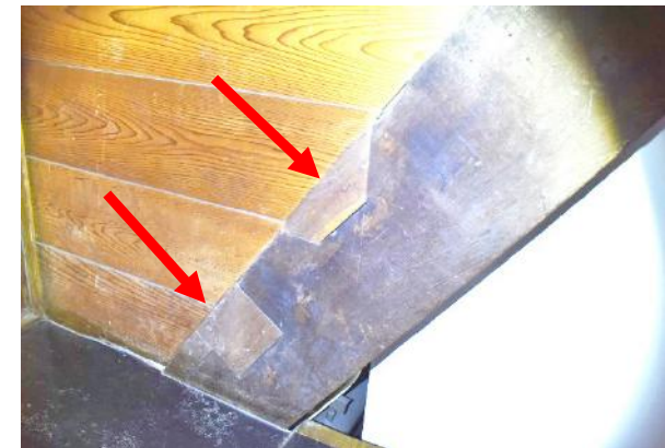
Gebint 23 B-zijde inzetstuk in spantbeen ter hoogte van korbeel en twee inzetstukken onderzijde spantbeen
