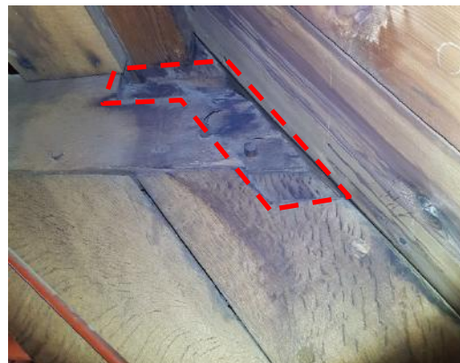
B-zijde, dichtgezette bovenhoek
