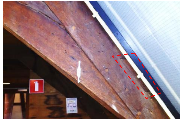
Gebint 23 A-zijde inzetstuk spantbeen ter hoogte van korbeel
