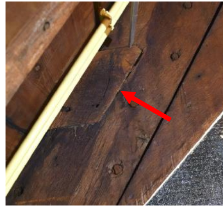
B-zijde, inzetstukken ter hoogte van korbeel
