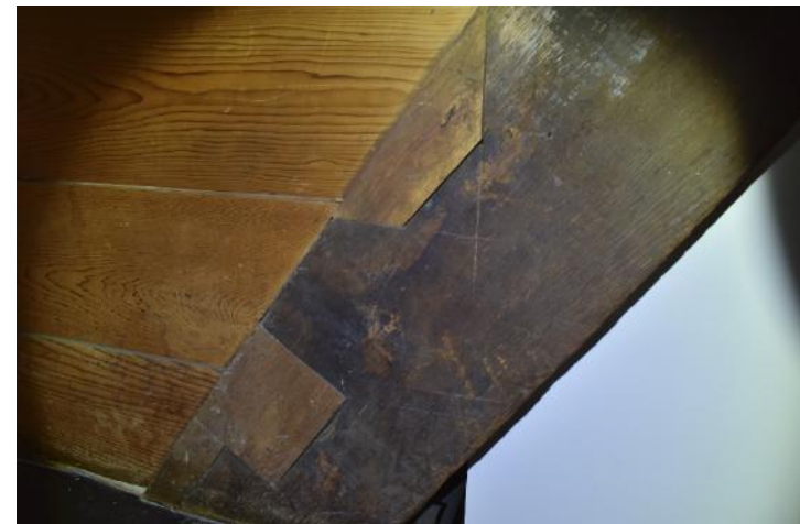
Linksboven: Afb. 5.45 Dekbalk gebint 15 met bouwspoor van oude aansluiting Midden boven Afb. 5.46 Mogelijk voormalige aansluiting fronton ter hoogte van korbeel. Rechtsboven: Afb. 5.47 Mogelijk voormalige boven aansluiting fronton Rechtsonder: Afb. 5.48 Mogelijk voormalige aansluiting dakkapel en fronton
