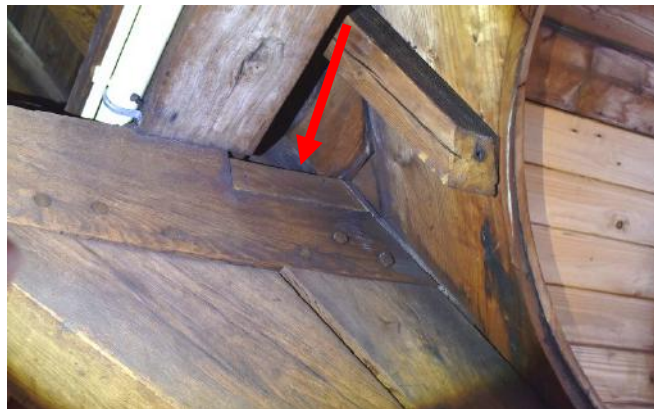
D-zijde, inzetstuk bovenhoek dekbalk
