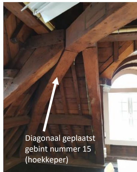
Afb. 3.12 t/m 3.14 Diagonaal geplaatste gebinten 09 en 15 bij overhoekse overgangen van de lange schilddaken met het noordoostelijk schild
