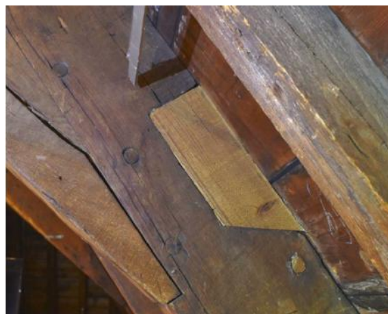
A-zijde, inzetstuk in spantbeen boven gording
