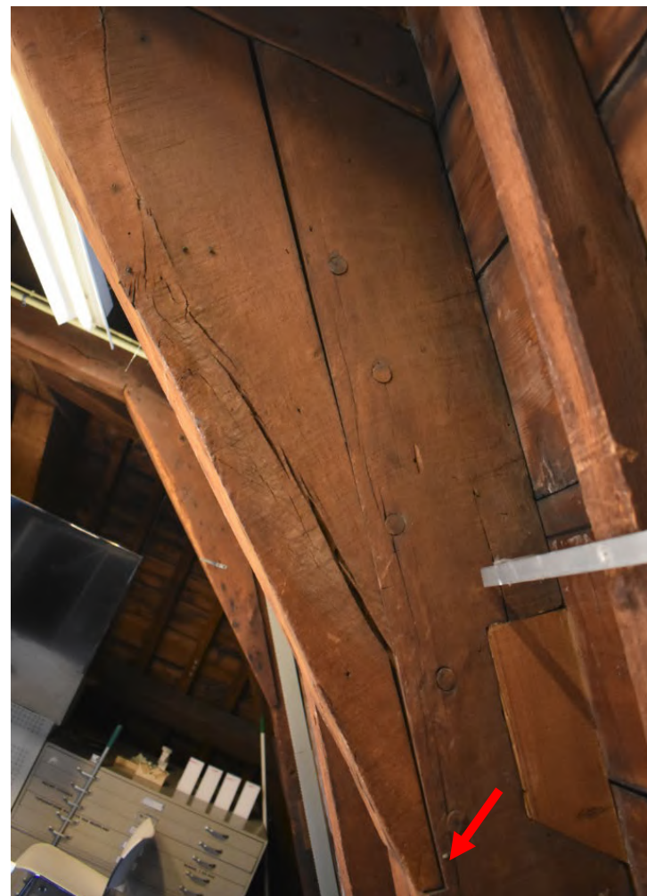
Afb. 3.21 Aansluiting korbeel met spantbeen (met tand)
