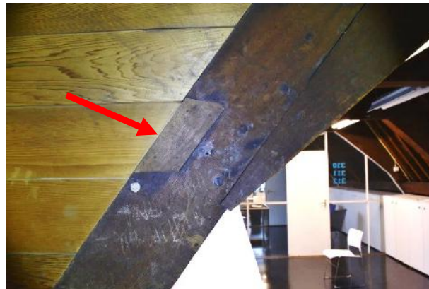
Gebint 23 B-zijde inzetstuk in spantbeen ter hoogte van korbeel en twee inzetstukken onderzijde spantbeen
