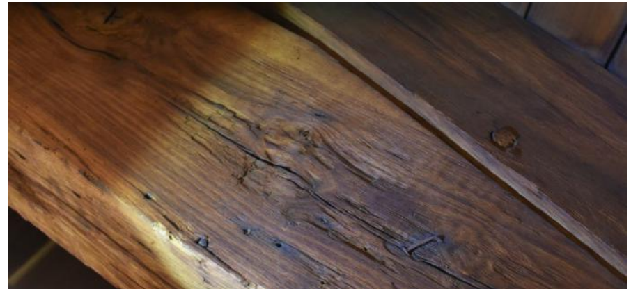
Boven Afb.3.44 Dekbalk met behakt oppervlak Onder Afb. 3.45 Korbeel met behakt oppervlak
