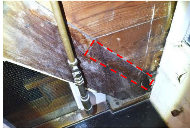
Gebint 19 A-zijde inzetstuk spantbeen
