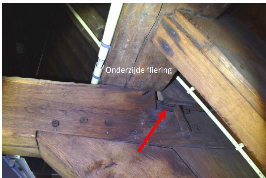
Afb.3.28 Aansluiting fliering op dekbalk, rechtsonder de fliering een inkeping zonder functie
