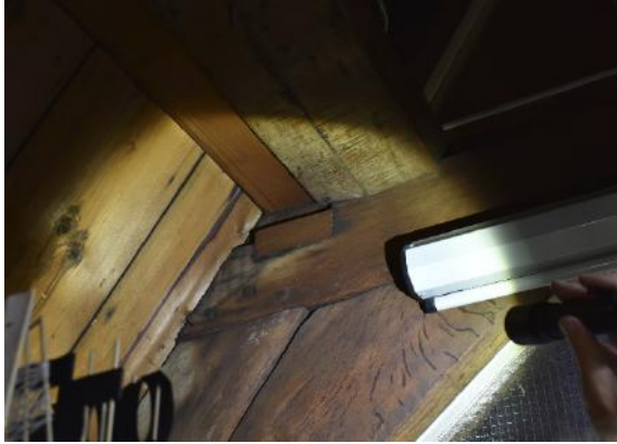
Gebint 06, inzetstuk bovenhoek dekbalk (beide zijden)
