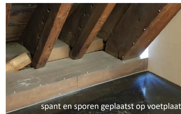
Afb. 3.17 Aansluiting spantbeen en sporen op voetplaat
