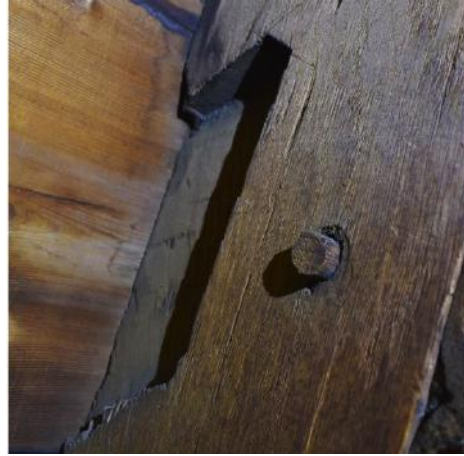
B-zijde, sparing ter hoogte van korbeel
