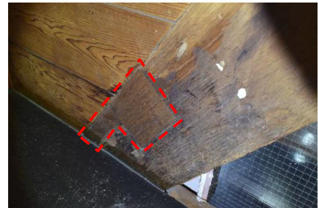
Gebint 20 B-zijde inzetstukken spantbeen
