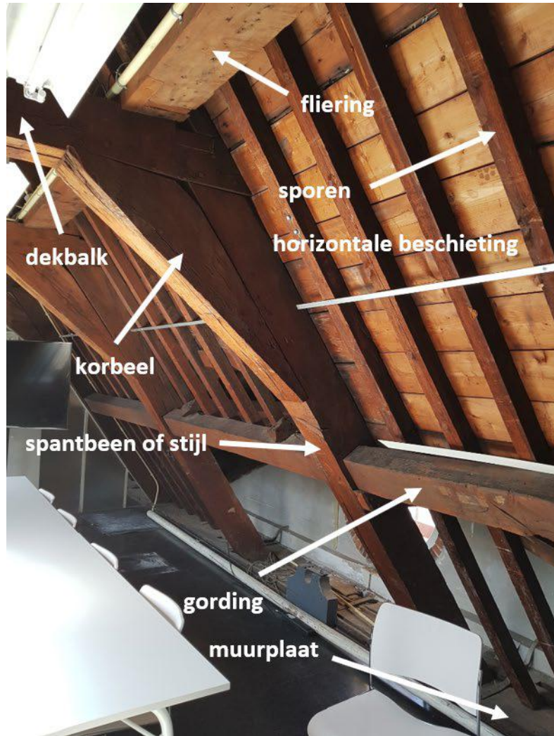
Afb.3.10 Onderdelen ter hoogte van de schaargebinten
