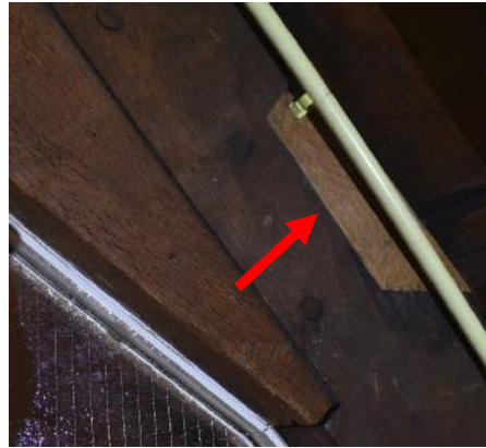
A-zijde, inzetstuk ter hoogte van korbeel
