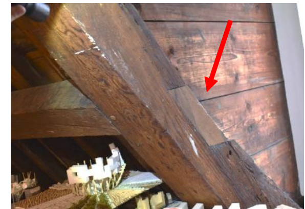
D-zijde inzetstuk ter hoogte van gording (dakkapelzijde)
