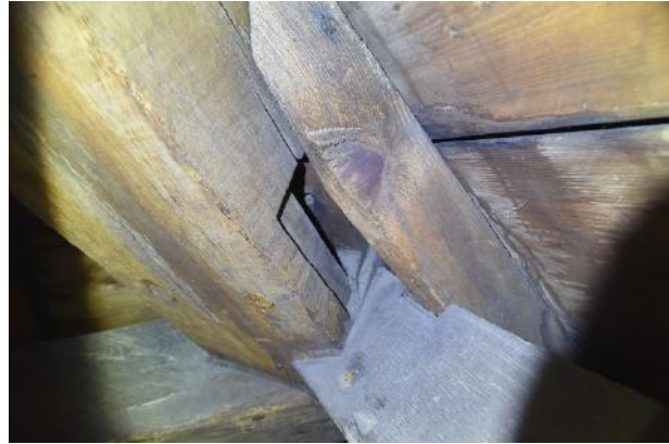
Halfgebinten/hoekkepers 25,27,28 en 29 zijn vervaardigd met spantbenen van volledige gebinten. De sparingen ten behoeve van voormalige pen- en gat verbindingen zijn loodrecht op het zijvlak
