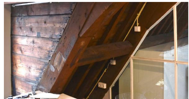
Linksboven Gebint 15, hoekkeper verlengd met liplas, bouwsporen ter hoogte van gording Boven midden: halfspant 14, uitkeping met voorloef en middendam Linksonder Gebint 15, verbinding met gording, dichtgezette sparing Onder midden: Halfspant 17, ter plaatse van dakkapel Rechtsonder: Halfspant 17, dichtgezette sparing t.p.v. gording
