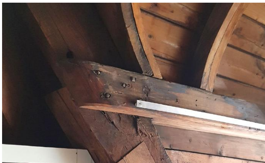
Afb.3.77 Ribben dakkapel vergelijkbaar met ribben frontons en eveneens bevestigd met gesmede spijkers
