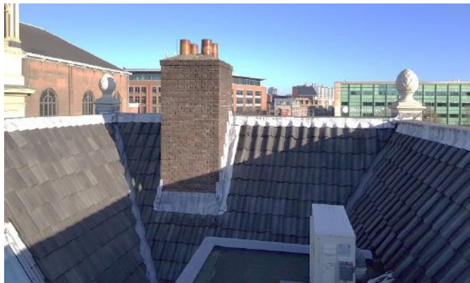
Afb. 3.05 Binnenste dakschilden gezien richting noorden
