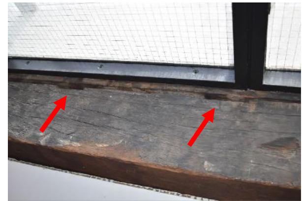
Gording binnen-dakschild, inkepingen (voormalige daksporen)
