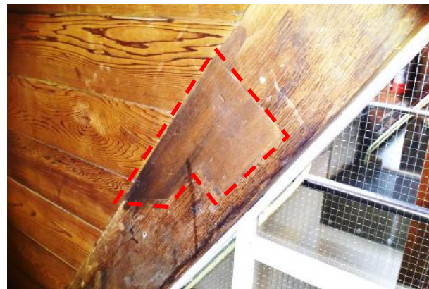
Gebint 20 B-zijde inzetstuk spantbeen
