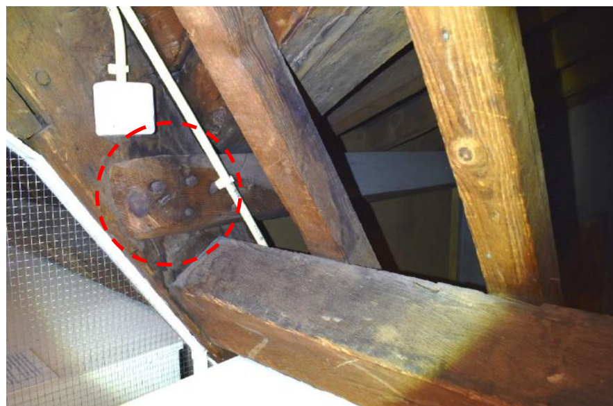
Afb.3.76 Ribben bevestigd met gesmede spijkers
