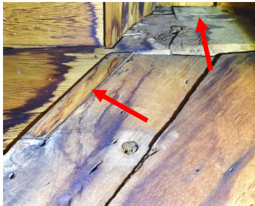
A-zijde, inzetstuk vlak onder dekbalk
