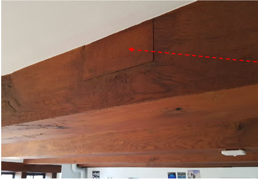
Afb.5.49 Dichtgezet gat of inkeping in de balken van de eerste verdiepingvloer Hier zichtbaar in het plafond van de tussenverdieping
