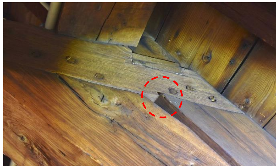
Afb.3.19 Verbinding spantbeen met dekbalk (met tand)
