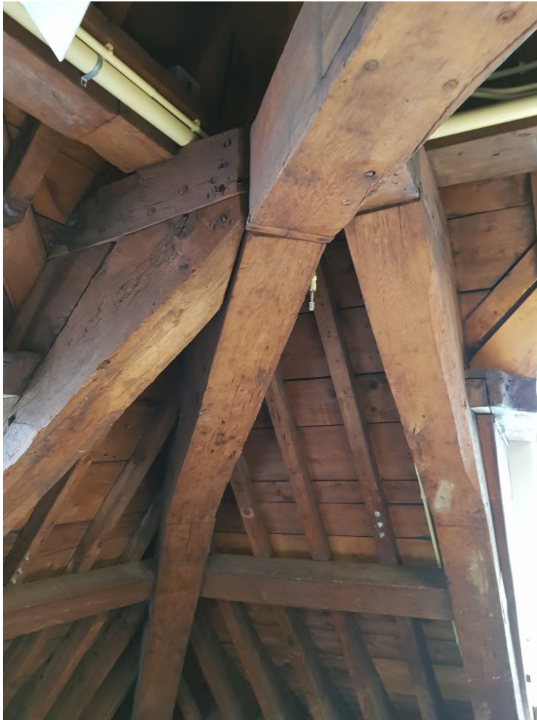
Afb.3.47 Overhoeks gebint 15 met halfspanten 14 en 16.
