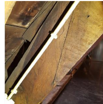
B-zijde, verlengd spantbeen met lipas
