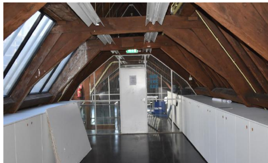
Afb.2.05 Zoldergebinten kap achterhuis
