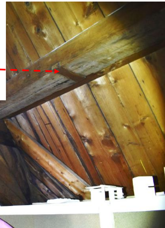
Afb. 5.39 Vloerconstructie ontwerptekening Blokhuisen Rechtsboven: Afb. 5.40 Aansluiting en hart op hart afstand vloerbalken Rechtsonder: Afb. 5.41 Onderzijde fliering OZ-Huiszittenhuis
