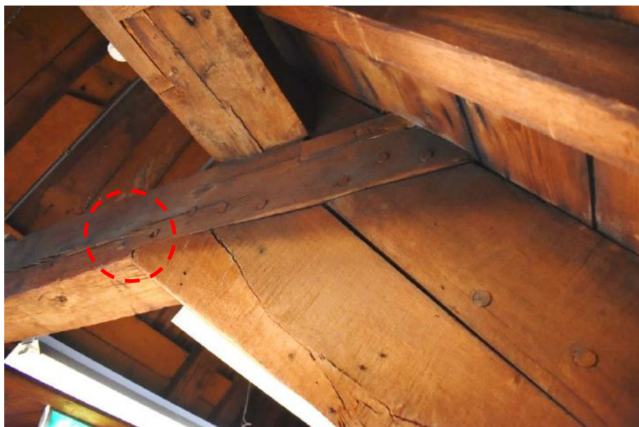
Afb.3.20 Aansluiting korbeel met dekbalk (met tand)
