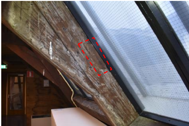
Gebint 22 A-zijde inzetstuk in spanbeen ter hoogte van korbeel
