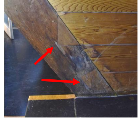
B-zijde, twee inzetstukken in spantbeen
