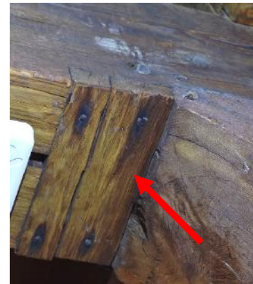
Onderzijde dekbalk, aanpassing korbeel
