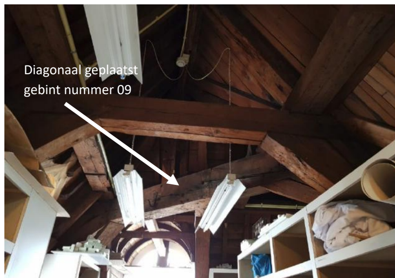
Afb. 3.12 t/m 3.14 Diagonaal geplaatste gebinten 09 en 15 bij overhoekse overgangen van de lange schilddaken met het noordoostelijk schild
