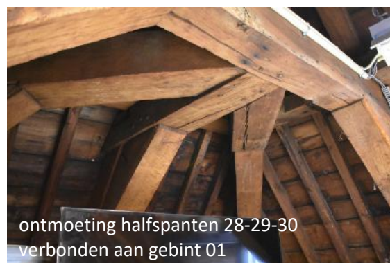
Afb. 3.15 Ontmoeting lange dakschilden met korte dakschild achterhuis Afb. 3.16 Idem ter plaatse van voorhuis
