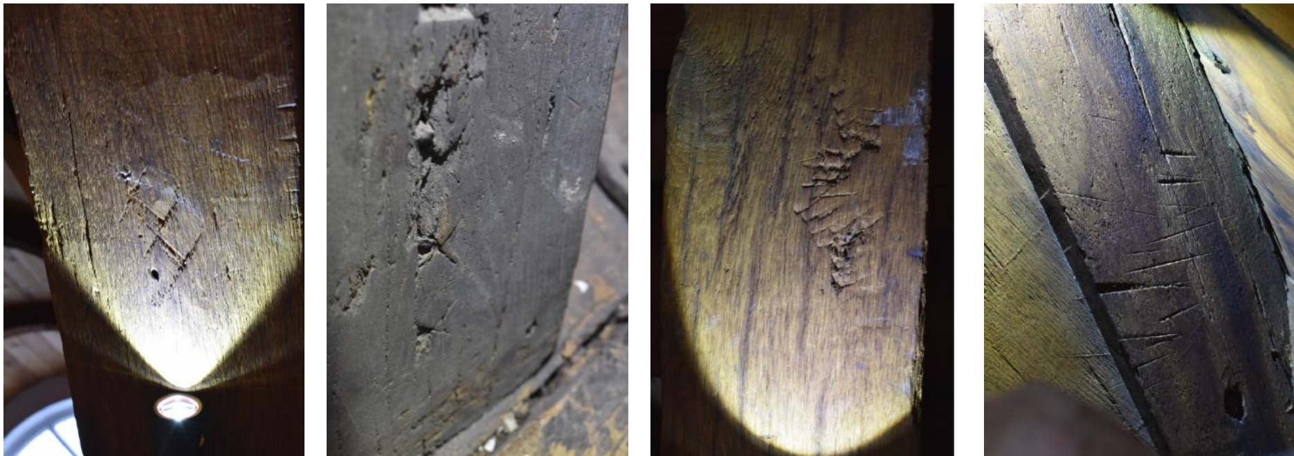
Afb. 3.61 t/m 3.65 Aangetroffen inkervingen op spantbenen (beschadigingen of sporen van timmermansmerken?)
