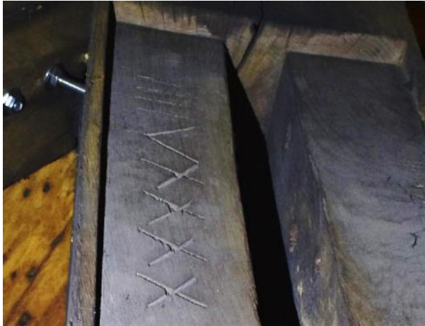
Afb. 3.55 Telmerk op koningsstijl boven gebint 01
