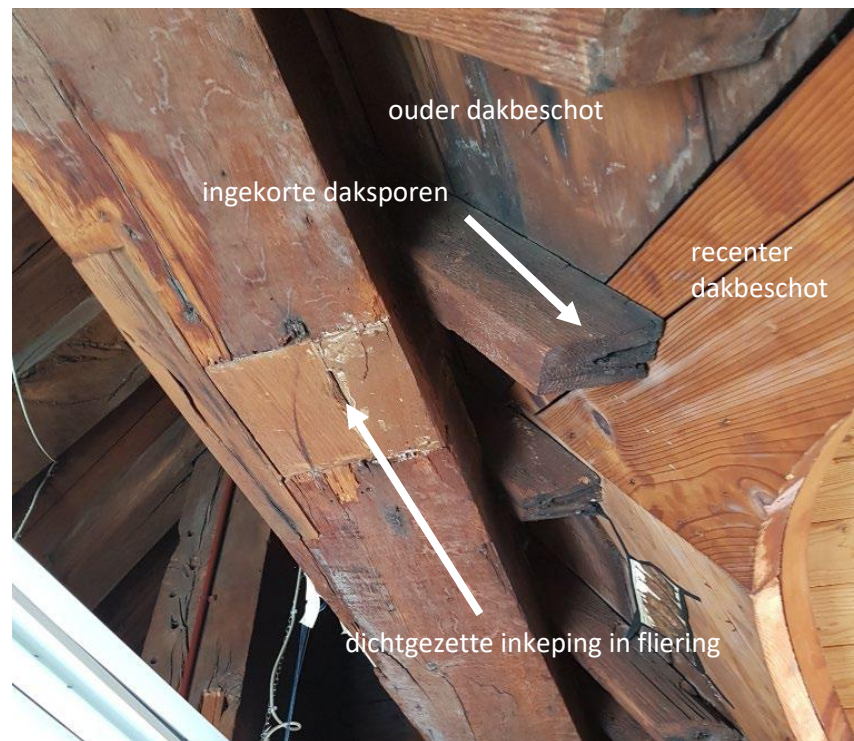
Afb. 4.03 Detail aansluiting bovenzijde dakkapellen Het verschil in verwerking van dakbeschot en de ingekorte daksporen
