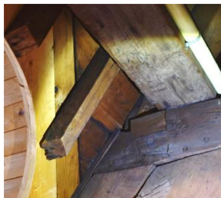
Linksboven Gebint 15, hoekkeper verlengd met liplas, bouwsporen ter hoogte van gording Boven midden: halfspant 14, uitkeping met voorloef en middendam Linksonder Gebint 15, verbinding met gording, dichtgezette sparing Onder midden: Halfspant 17, ter plaatse van dakkapel Rechtsonder: Halfspant 17, dichtgezette sparing t.p.v. gording
