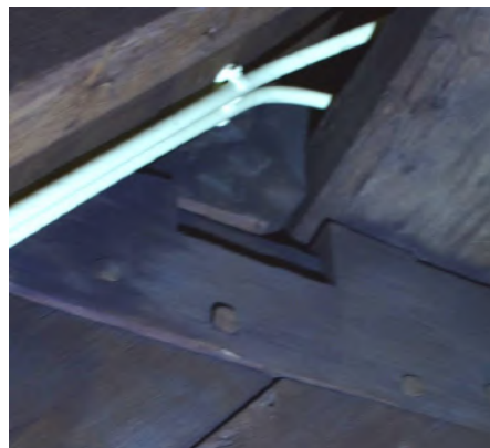
B-zijde, uitkeping met voorloef/middendam
