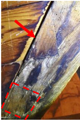
Gebint 04 A-zijde, drie inzetstukken in spantbeen
