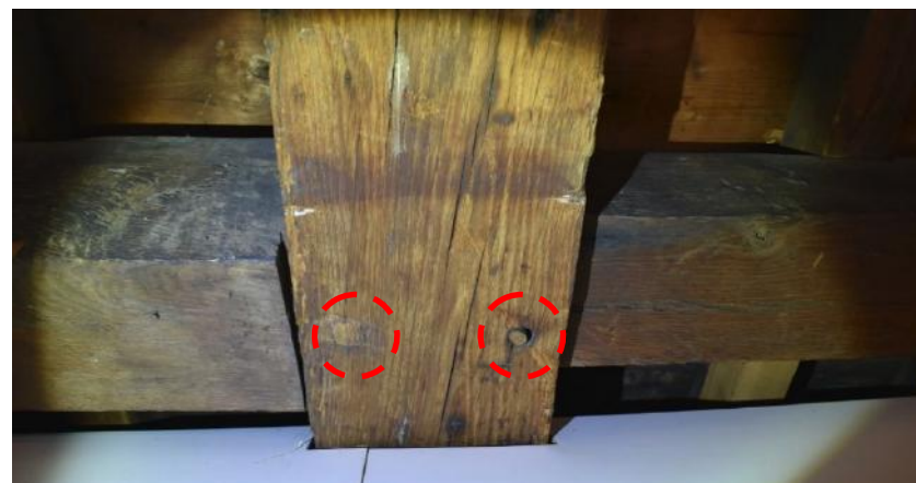
Afb.3.27 De gordingen zijn door middel van toognagels verankerd met de spantbenen
