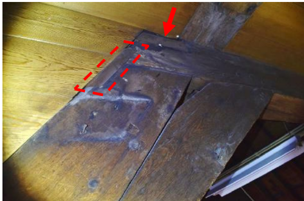
Gebint 23 B-zijde inzetstukken in spantbeen en bovenhoek dekbalk
