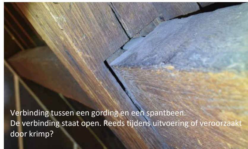
Afb.3.26 Pen-en-gat verbinding gording en spantbeen
