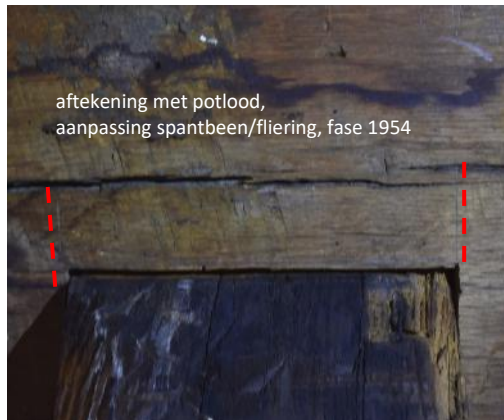
Gebint 05 aanpassing spantbeen binnen dakschild
