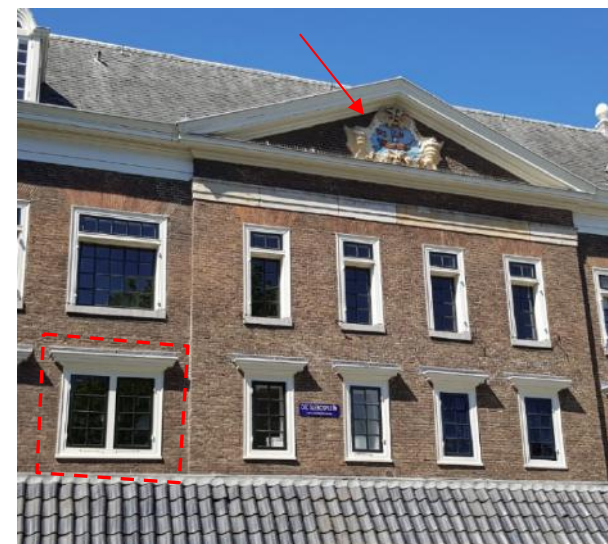
Afb. 5.19 Achtergevel OZ-Huiszittenhuis met oorspronkelijk venster
