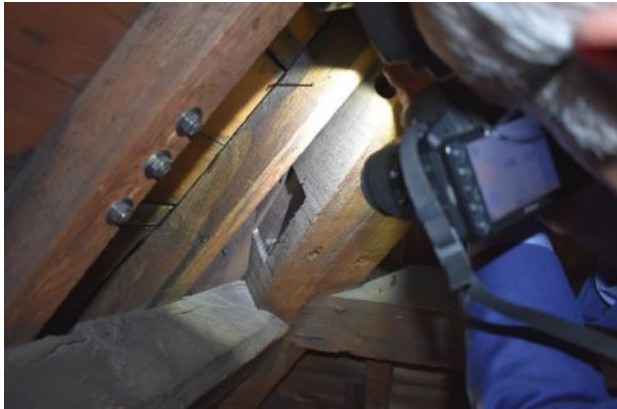
Halfgebinten/hoekkepers 25,27,28 en 29 zijn vervaardigd met spantbenen van volledige gebinten. De sparingen ten behoeve van voormalige pen- en gat verbindingen zijn loodrecht op het zijvlak
