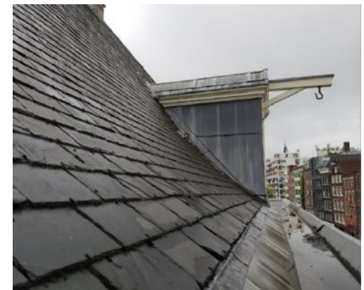
Afb. 3.06 Gootaansluiting en zijkant dakkapel
