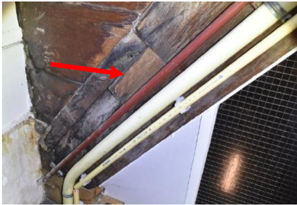
Gebint 18 B-zijde inzetstuk spantbeen
