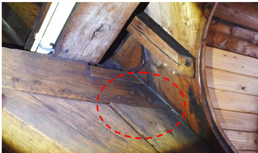
Afb.3.18 Verbinding spantbeen met dekbalk (zonder tand)
